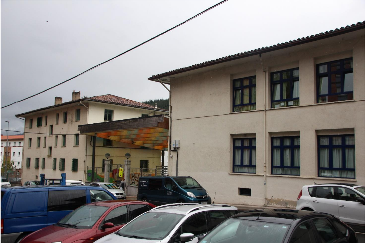
Iparaldeko sarrera, Elkano kaletik. Entrada norte al conjunto por la C/ Elkano.
