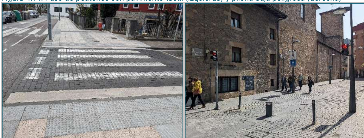
Figura 4.14. Paso de peatones con pavimento táctil (izquierda) y piona baja peligrosa (derecha)
