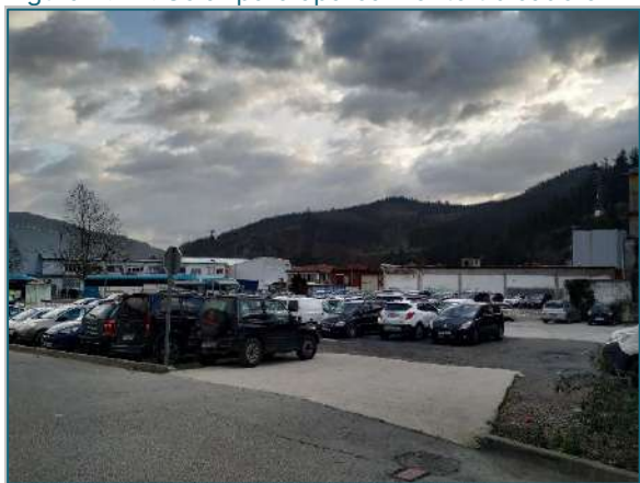
Figura 4.111. Solar para aparcamiento ubicado en Zalduspe
