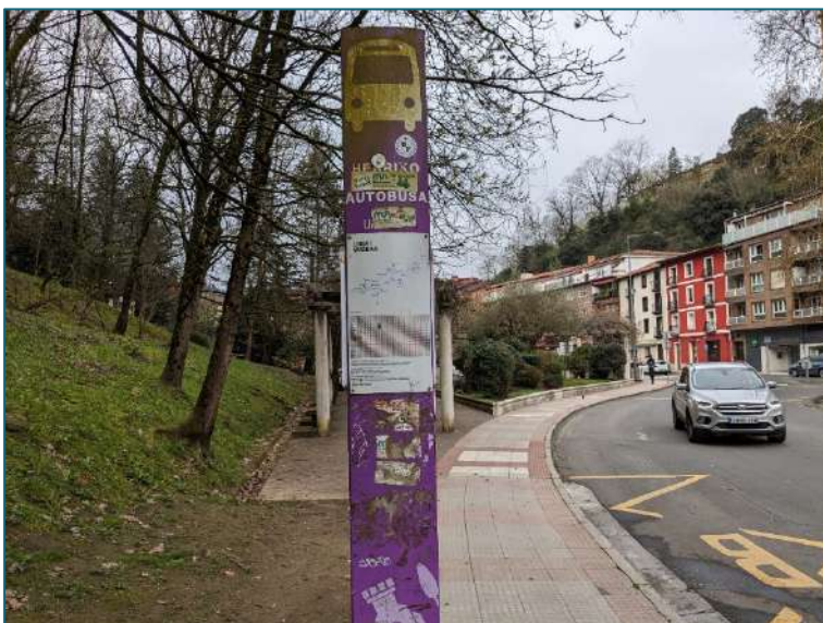
Figura 4.64. Palo de parada del servicio de autobús urbano en Otalora Lizentziatua en mal estado de conservación
