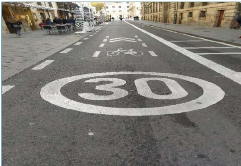
Figura 4.52. Ejemplo de señalización de itinerario de bicicletas en calzada en zona 30 en la ciudad de Vitoria-Gasteiz
