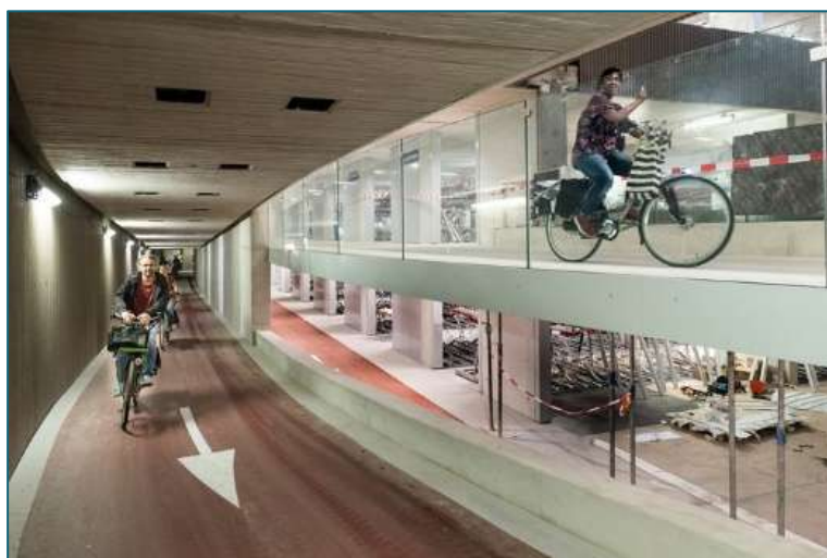
Figura 4.58. Aparcamiento de bicicletas subterráneo en la estación central de Utrecht (Países Bajos)
