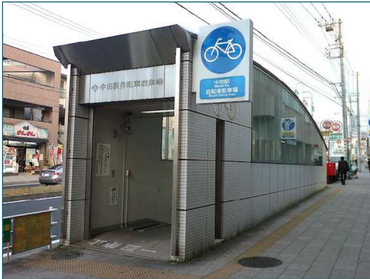
Figura 4.34. Entrada de aparcamiento de bicicletas en Yokohama (Japón)
